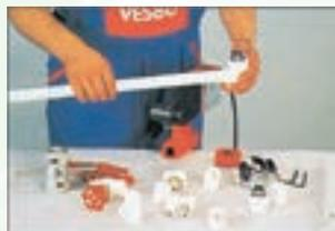
Cuando se haya alcanzado el tiempo de calentamiento, retire la tubería y el accesorio al mismo tiempo, otra vez sin torcer ni dar vueltas mientras lo retira del equipo de fusión. Es posible ajustar la unión máx. 5 grados durante este tiempo. Después de completar estos 3 pasos se ha terminado la unión por termofusión.
