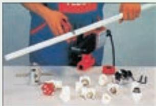
Corte la tubería a la longitud necesaria utilizando tijeras corta tubos, marque la profundidad de fusión en la tubería, asegúrese que el indicador luminoso del equipo de fusión se encuentra a 260°C, para fusionar.
