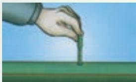
4. Saque el tarugo para reparaciones y retire el fusionador de la tubería, inserte la reparación en el orificio que quedó sin girar. Espere 15 seg.
