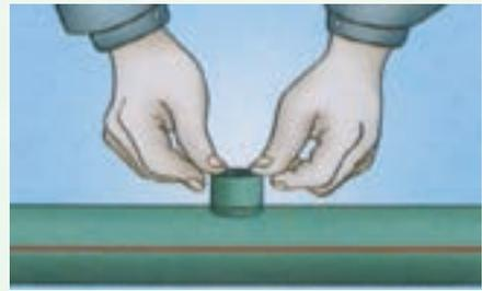
4. Una vez que el proceso de calentamiento está terminado quite la fusora y empuje la espiga de montura en el orificio de la tubería con una ligera presión hasta que las superficies acoplen por completo. Mantenga pulsado durante unos 15 a 20 segundos. Luego de 20 minutos de estar fría la tubería puede hacer la prueba de presión.
