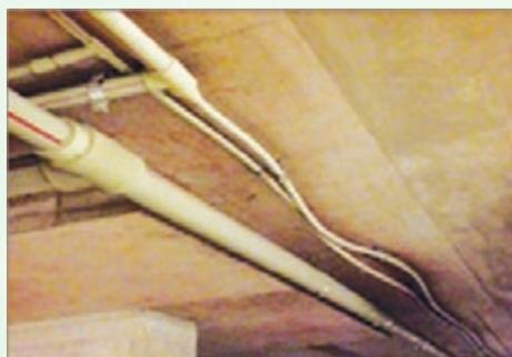
PP-RCT BETA: Presencia de curvatura en instalaciones de agua caliente.
